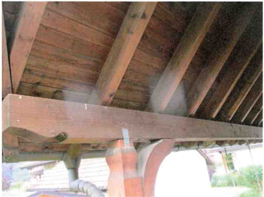
Abb. A3: Dachüberstand auf der westlichen Gebäudeseite (bleibt erhalten)
