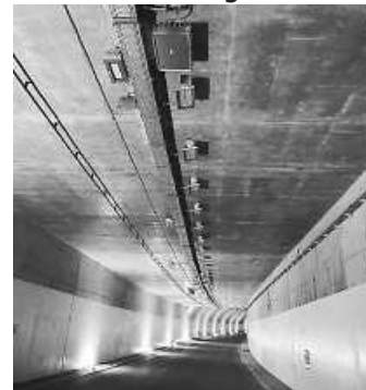
Tunnel Portal West Richtung Ost Foto: Marita Schmieder
